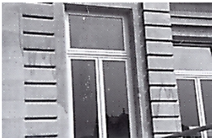
Afb. 3 "Lopers" na behandeling met ethylsilicaten.
