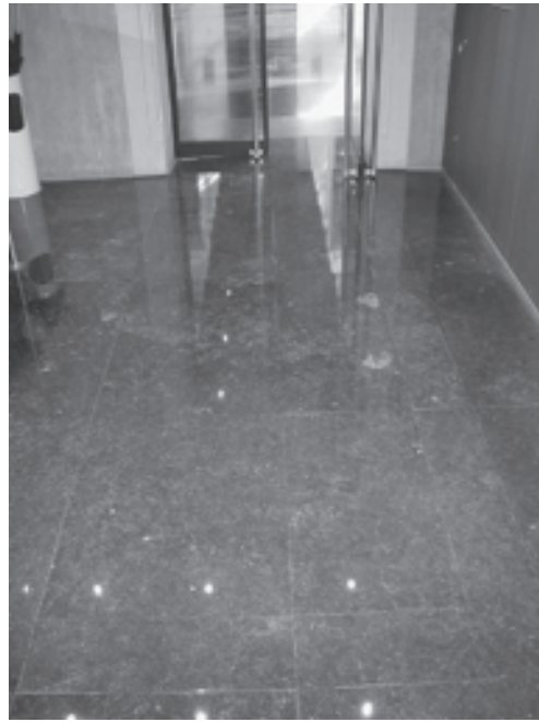
Afb. 15 Gekristalliseerde vloer. Kristallisatiebehandelingen worden o.a. gebruikt voor de renovatie van vloeren die dikwijls zeer oud kunnen zijn. In dergelijke gevallen wordt de slipweerstand sterk gewijzigd.
